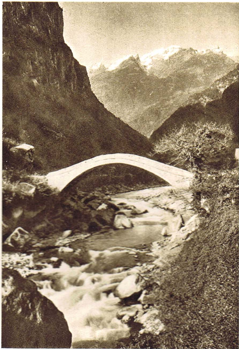
La Deveria. Pont sur la rivière.
